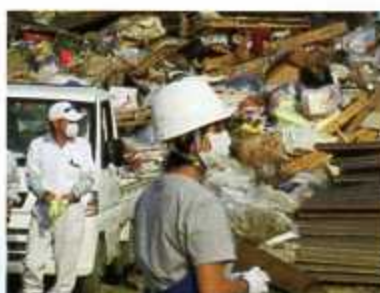
災害廃棄物処理現場
